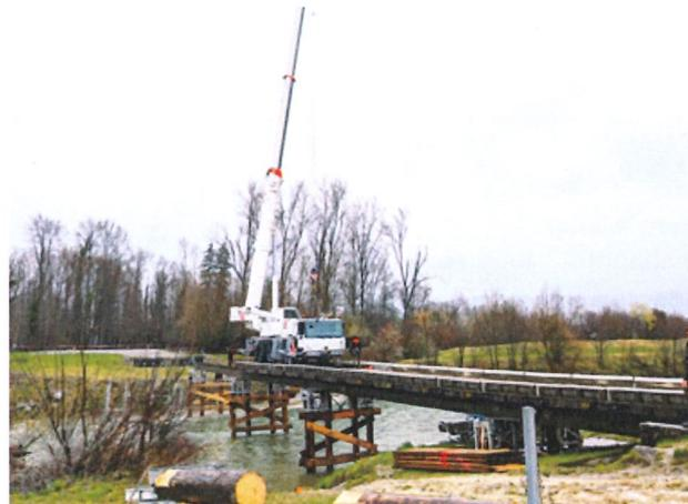
Trotz intensiven Regenfällen und einem damit verbundenen beträchtlichen Anstieg des Wasserstands der Thur haben die Sappeure des Geniebataillon 23 eine knapp 70 m breite Stahlträgerbrücke in rund 25 Stunden über die Thur errichtet. Diese Brücke wurde 300 Meter unterhalb der bestehenden Strassenbrücke zwischen Märstetten und Amlikon-Bissegg an einer vorbereiteten Übersetzstelle gebaut.
